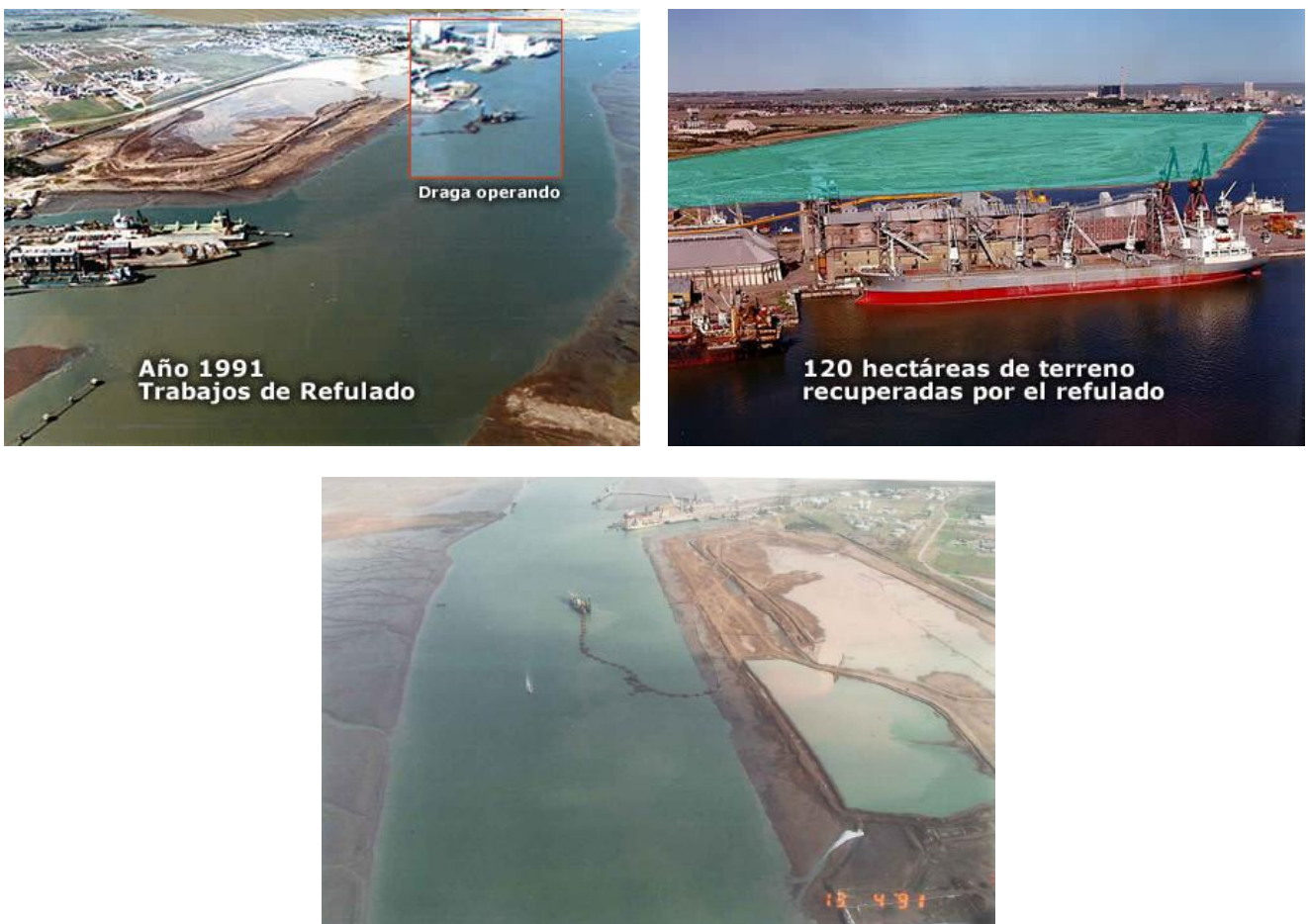
Figura 3. Refulado en Sector de Cangrejales. Fuente: CGPBB http://www.puertobahia blanca.com/servicios_cangrejales.asp
